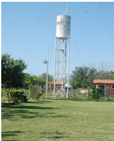
Tanque de agua
